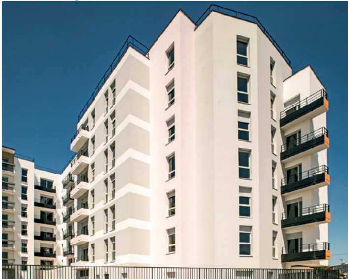
LA PROUE DE LA FAÇADE ARRIÈRE
