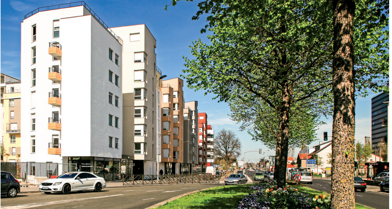
FAÇADE PRINCIPALE SUR L'AVENUE DU GÉNÉRAL DE GAULLE
